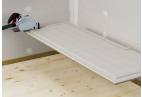
Absägen des überstehenden Falzes für die 1. Verlegereihe
