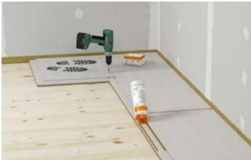
Auftragen des fermacell™ Estrich-Klebers im Falzbereich / Fixierung mit Klammern oder Schrauben
