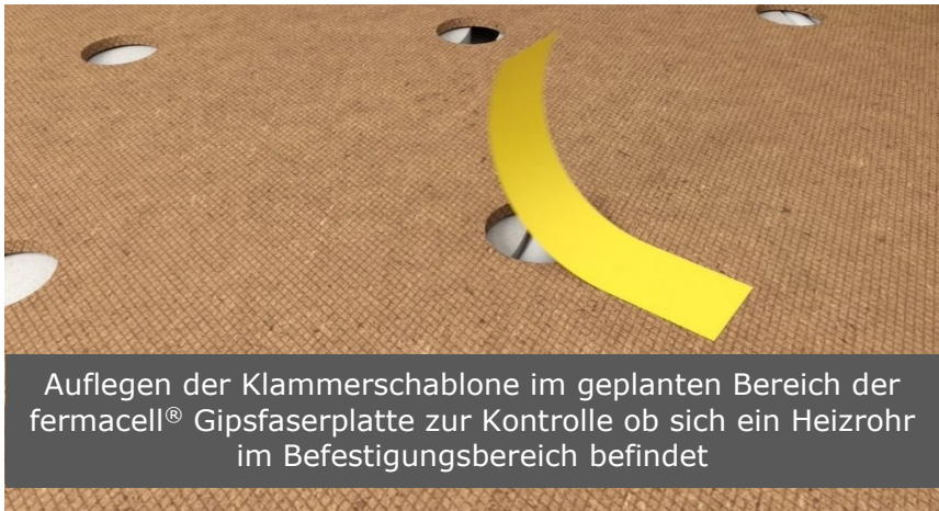
Klammerschablone als Hilfsmittel für die Befestigung der fermacell® Gipsfaserplatte
